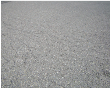
En haut: chaussée non compatible pour le scellement de fissures En bas: trou trop gros pour scellement mais parfait pour Aquaphalt
