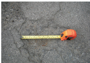
En haut: chaussée non compatible pour le scellement de fissures En bas: trou trop gros pour scellement mais parfait pour Aquaphalt
